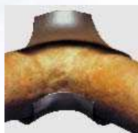
Montajul unui cot preformat
