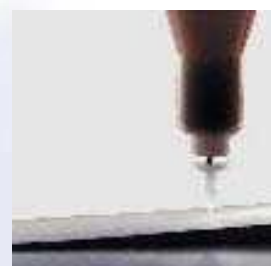
Inchiderea marginilor longitudinale cu nituri din plastic la presiune
